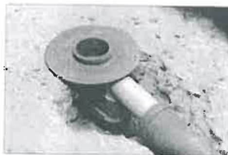
Сифонът се монтира в най-ниските места на водопроводните подове. Решетките на подовите сифони ще бъдат наравно с пода.
